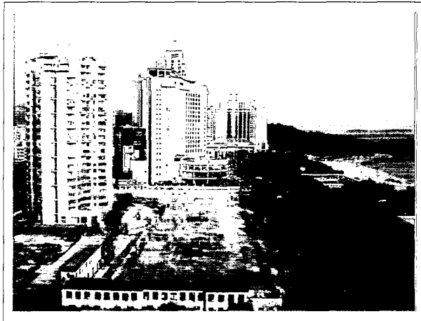
海天花園建築地盤
