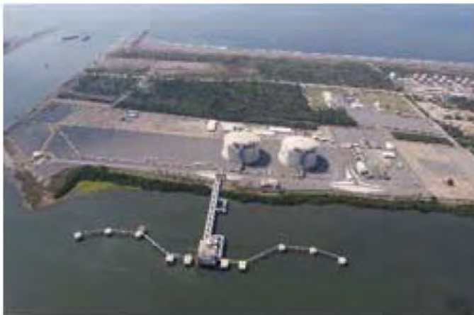
Manzanillo LNG Terminal
